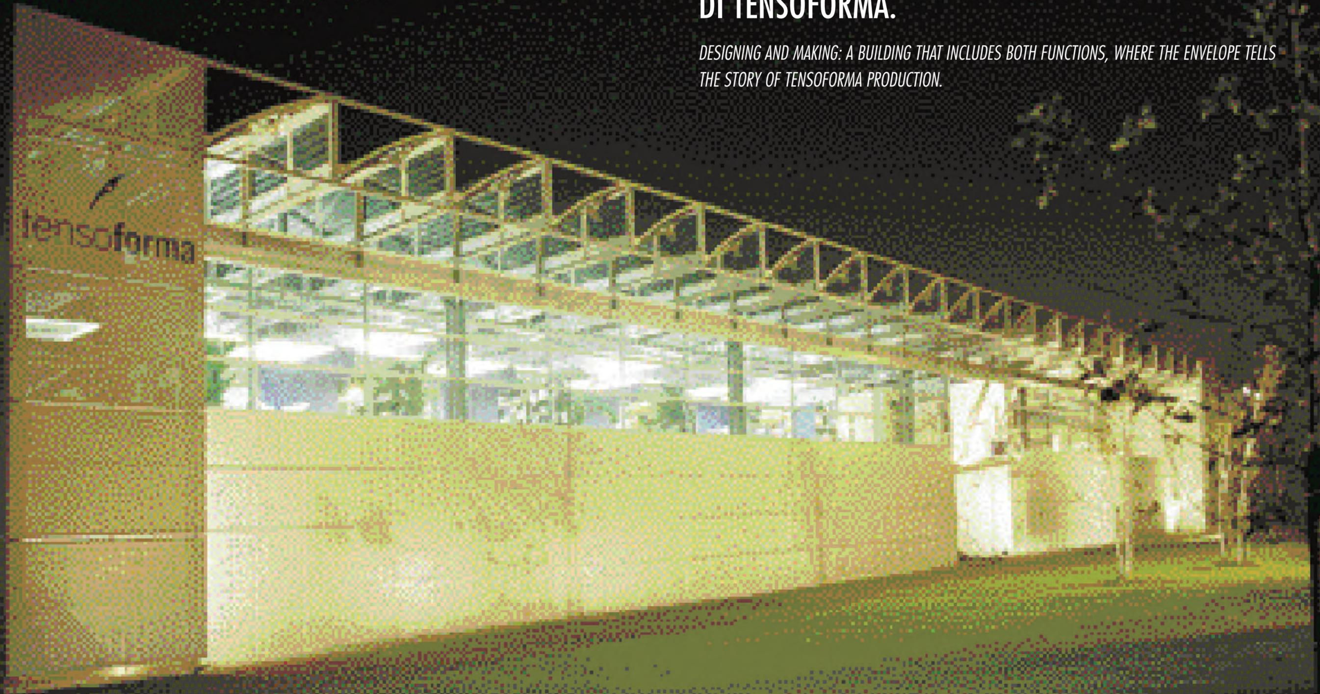
1. Il sistema di involucro. In primo piano il tamponamento tessile e le ali in acciaio in copertura. L'aggetto della copertura permette di escludere la radiazione diretta durante il periodo surriscaldato. Nel periodo sottoriscaldato i pannelli scorrevoli interni (movimentazione manuale) permettono di controllare i fenomeni di abbagliamento. Gli shed di copertura orientati verso nord garantiscono luce diffusa negli ambienti di lavoro.
